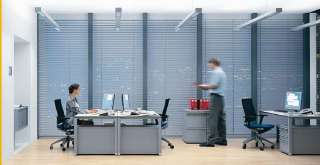
Eine verbreitete und bewährte Lösung für raumbezogene Beleuchtung mit Indirektlichtanteil gegen die Decke. (© Zumtobel)
