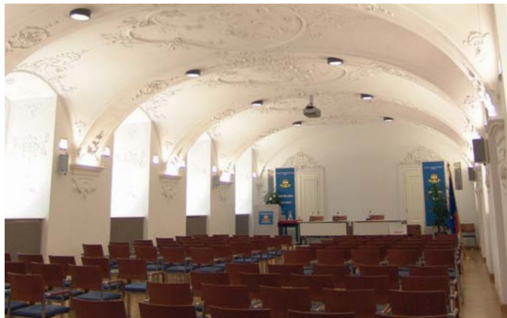
Die Sala Terrena in der Stiftskaserne wurde von Ferencsin Lichtdesign mit Direktlicht als Arbeitsplatzbeleuchtung und mit Indirektbeleuchtung zur Akzentuierung der Architektur gestaltet. (© Ferencsin Lichtdesign)
